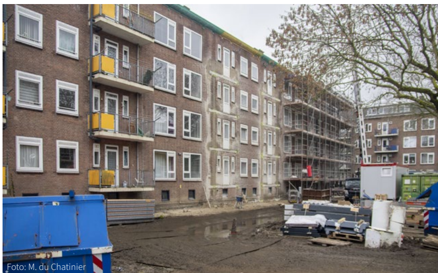
Foto: M. du Chatinier Volledige vernieuwing gevel
