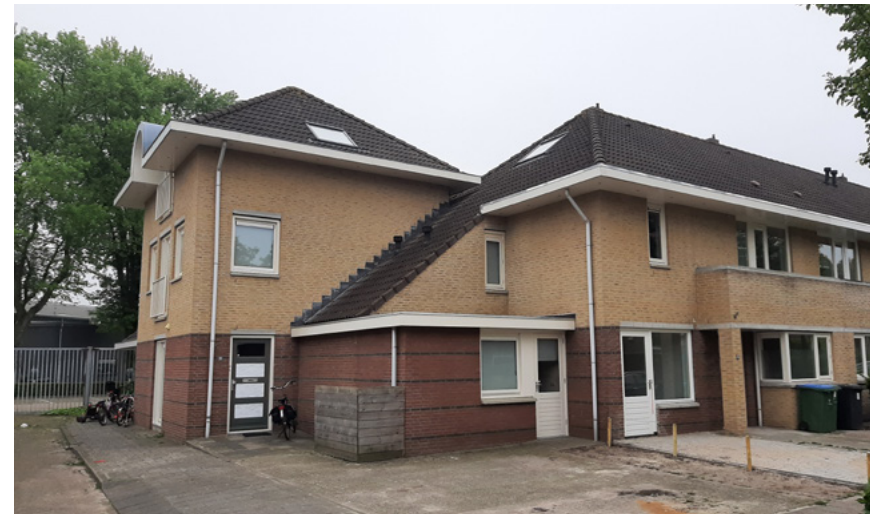
Figuur 22 Voor- en zijgevel van de gesplitste woning. De voordeur van de linker woning bevindt zich links bij de fiets. De voordeur van de rechter woning zit achter de pilaar bij de kliko's.
