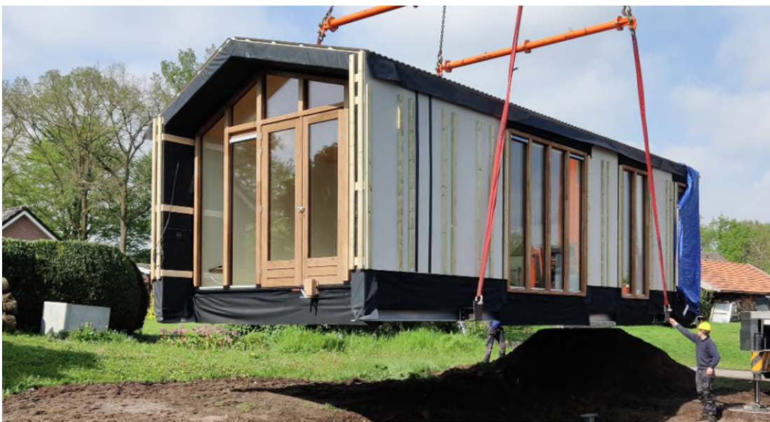
Plaatsing van de eerste 'Uuthuskes' in Aalten, zie voorbeeld 2.1
